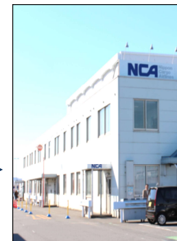
NCAの看板がある建物が事務所です (写真は第3・4事務棟です)
